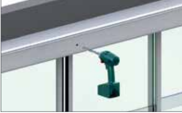
Alüminyum profil delme işlemi. / Drill a hole on aluminium profile.
